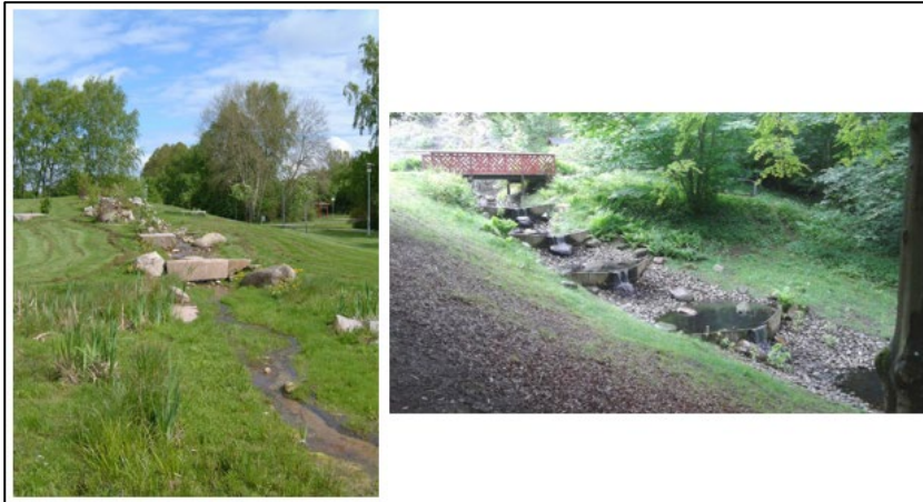
Figur 16 Exempel på sektionerade diken med överfall (Foto: Norconsult).
