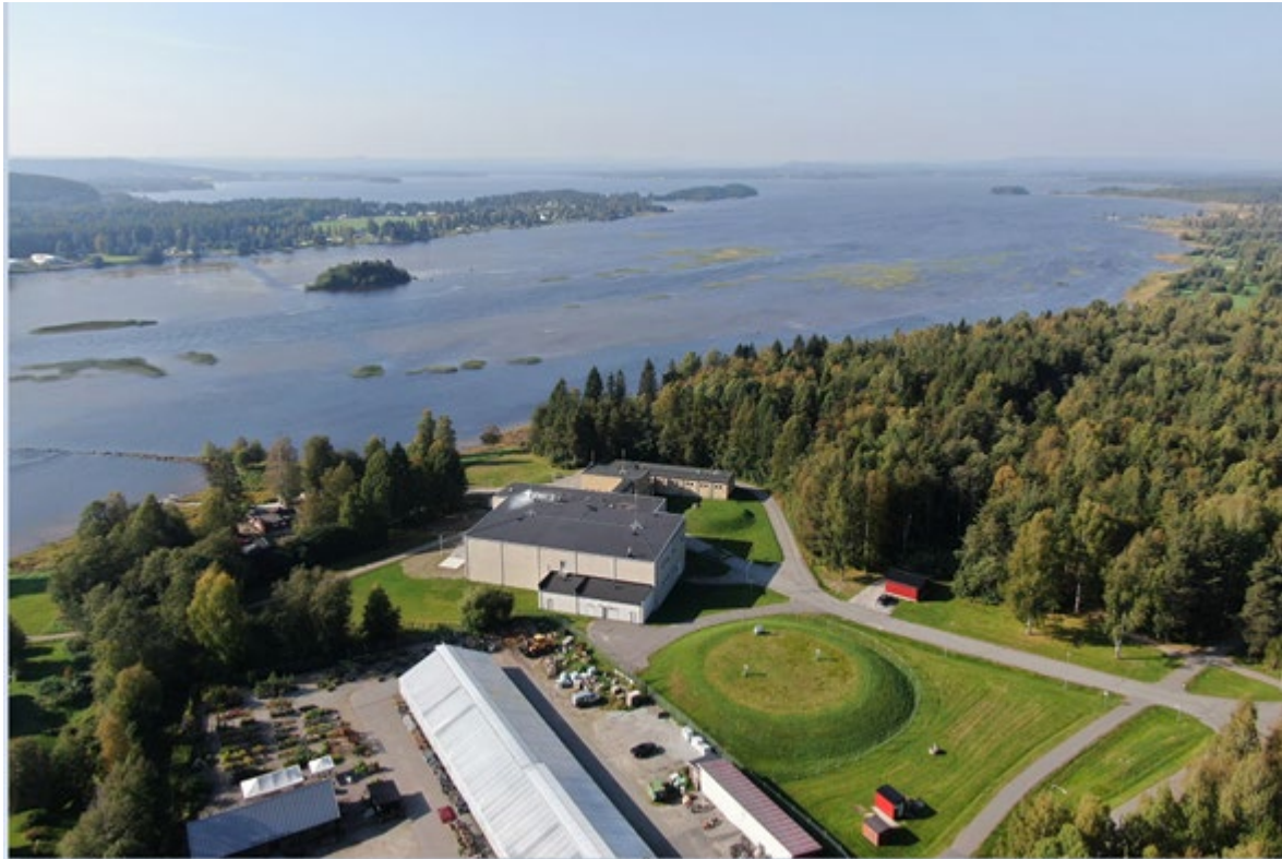
Figur 14. Drönbild över planområdet som visar det befintliga vattenverket centralt i bilden, handelsträdgården i nedre kant av bilden samt den tätortsnära skogen till höger i bild.
