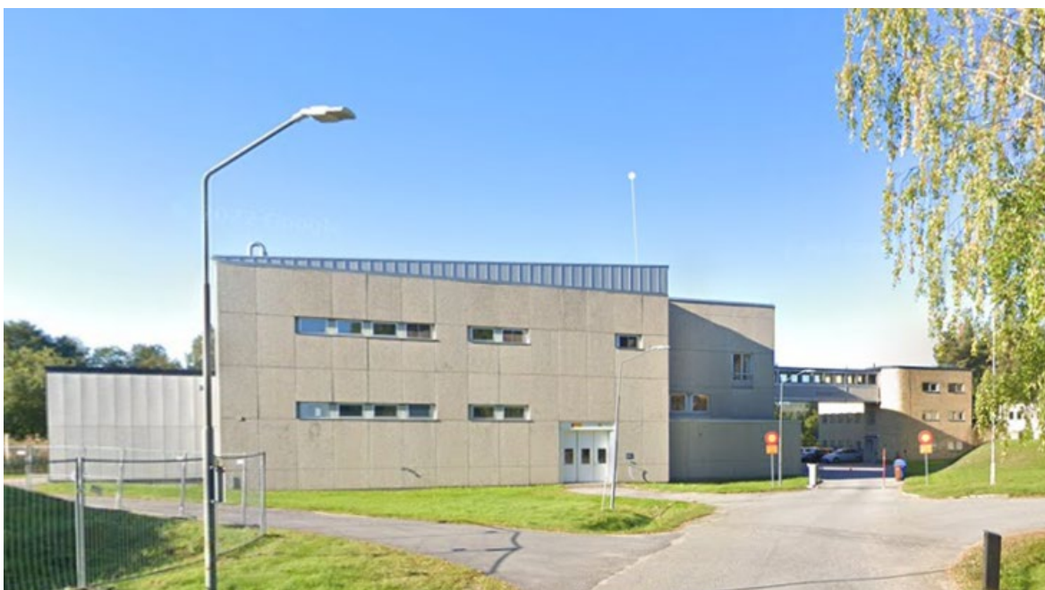
Figur 13. Foto på befintligt vattenverk. Källa: google maps.
