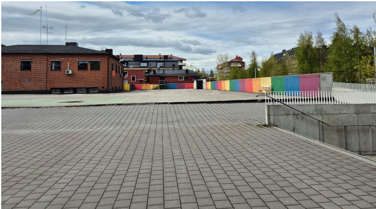
Figur 20 Foto taget mot väster av parkeringsgaraget inom planområdet. Trapp ner mot Sundsgatan ans till höger i bild.
