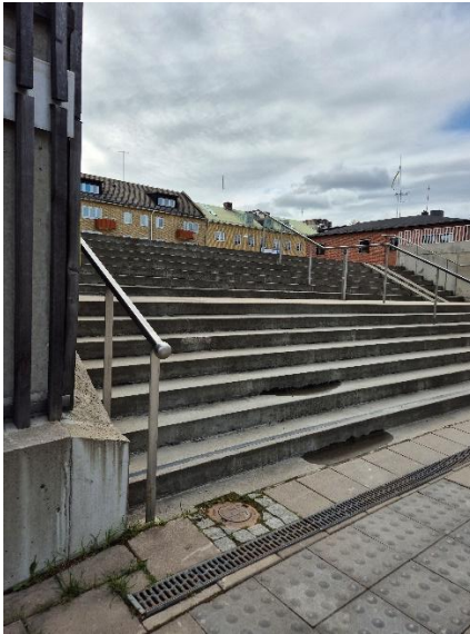
Figur 5 Trappa upp mot planområdet från Sundsgatan.
