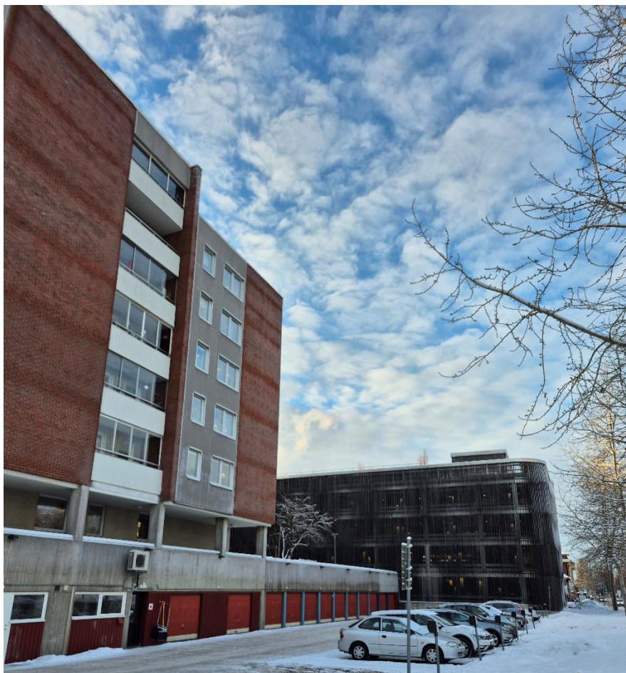
Figur 8 Foto över byggnaden taget från Sundsgatan med parkeringsgaraget Stadsberget i bakgrunden.
