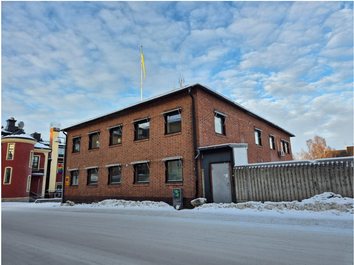
Figur 5 Foto på kontorshuset taget från Prästgårdsgatan.
