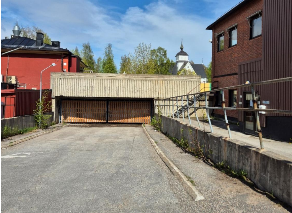
Figur 10 Befintlig angöring från Prästgårdsgatan till parkeringsgarage inom planområdet.
