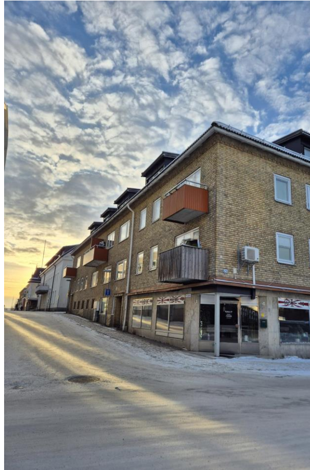
Figur 34 Vy från hornet Prästgårdsgatan Aronsgatan som visar att bebyggelsen mot centrum och närmre Rådhusorget har en skala i 2-3våningar.
