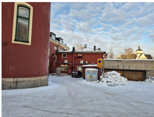
Figur 48 Tillbyggnaden från baksidan visar att den är sammanbyggd med parkeringsgaraget.
